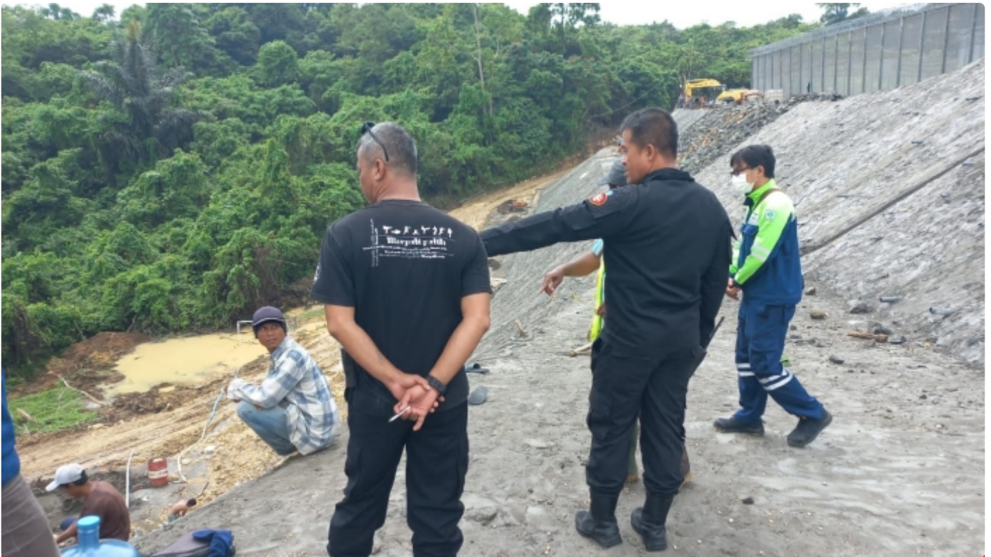
Garap Turap GRBB PT. SBI, Plt. Kalapas Karanganyar: Turap ini Sebagai Penahan Bencana Alam Tanah Longsor
